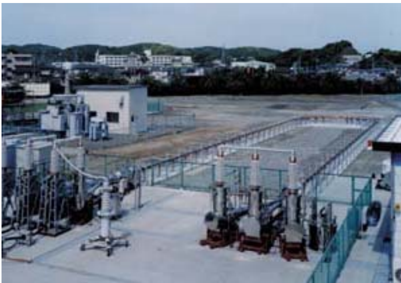
Figure 7. Essai sur le terrain d'un système de câble HTS triétagé 114 MVA, refroidi par un écoulement forcé d'azote liquide pressurisé (TEPCO, CRIEPI, SEI)
